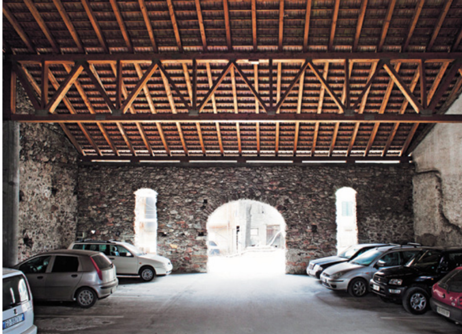
Der Bärenstadel in Laas im oberen Vinschgau wird heute als öffentliche Garage genutzt.
