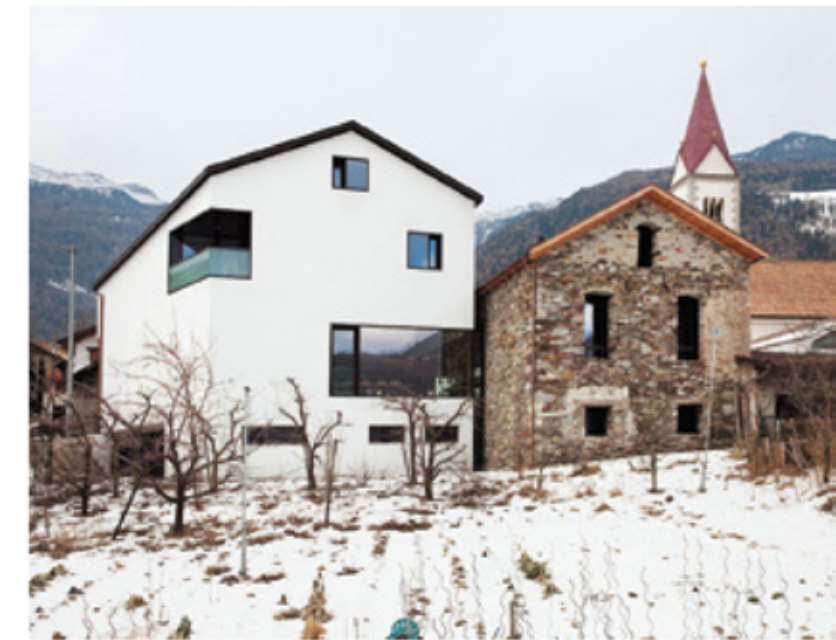
Neues Pfarrhaus und steinerner Stadel neben der Kirche in Tabland oberhalb Naturns.
